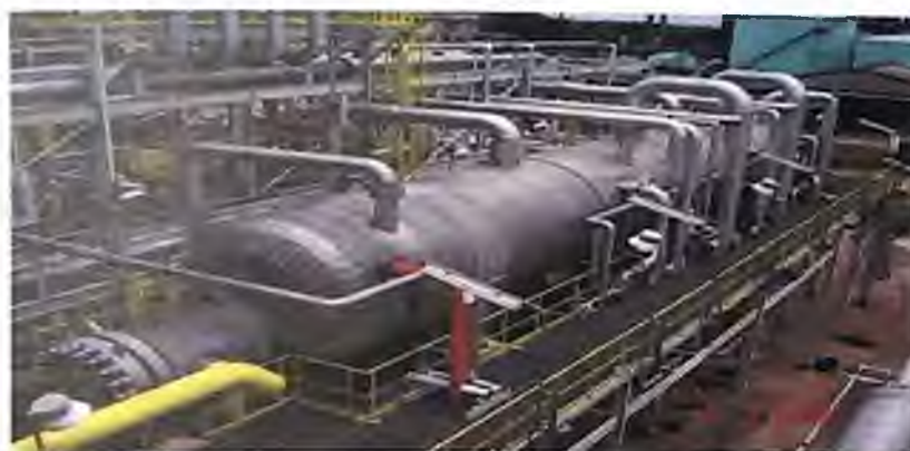
Рис. 4. Объединенный аммиачный испаритель KBR
