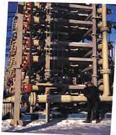
Рис. 4. Фотография блока мембранного разделения в структуре УМВГК Чаяндынского НГКМ
