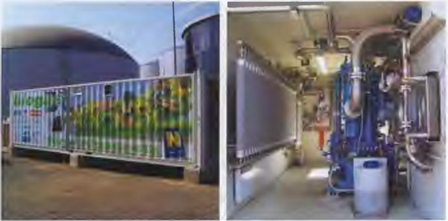
Рис.2. Вид снаружи и изнутри мембранного блока по кондиционированию биогаза. Внутри морского контейнера смонтированы половолоконные мембранные модули (слева) и компрессор (справа), который обеспечивает энергией функционирование завода в целом.
