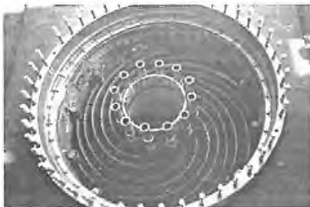
Рис. 9. Реконструкция реактора синтеза аммиака агрегата мощностью 200 000 т/год. Реактор перед загрузкой катализатора
