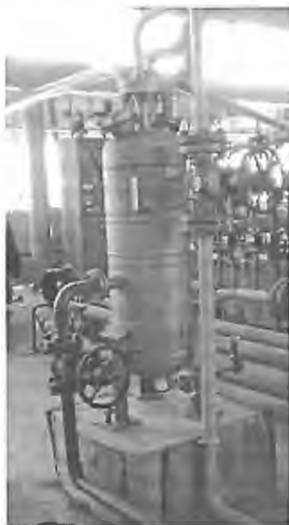
Рис. 10. Теплообменный аппарат ТА-4,2Р-4 конструкции «ФАСТ ИНЖИНИРИНГ» ® для охлаждения сжатого воздуха водой; мощность 215 кВт, P_{\text{раб}} = 7,0 \text{ МПа}
