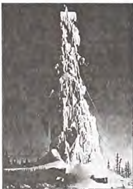
Рис. 3. Фотография газогидратов, образовавшихся в результате выброса газа и воды на буровой установке ( h = 42 м) в Якутии, 1963 г. ( T = -63 °С; P = 0,1 МПа). Эксплуатационная скважина Марха (Ю. Макогон)
