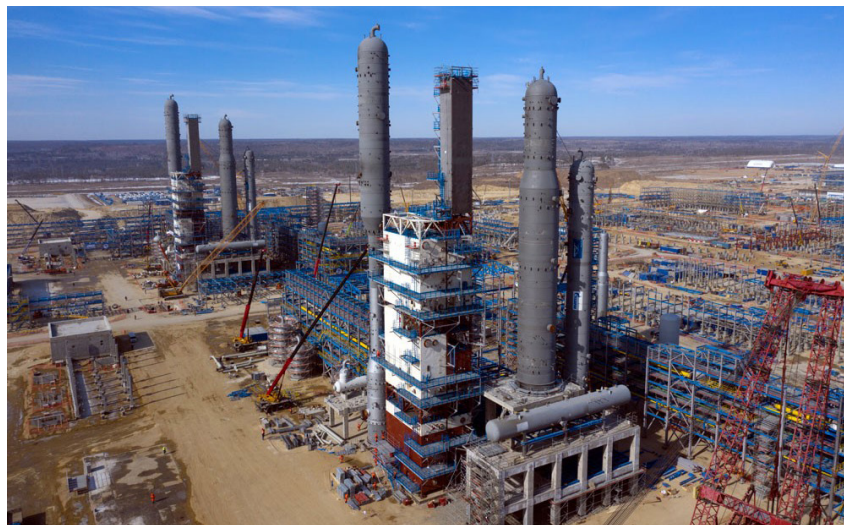
Рис. 3. Амурский ГПЗ на пике строительства [9]
